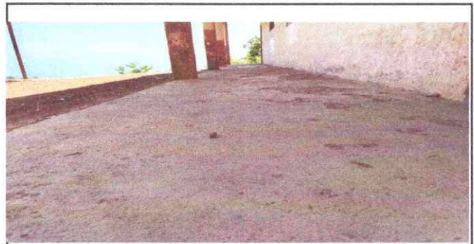
Foto 6: Se puede observar que el piso ya esta con demaciados agujeros tanto dentro y fuera del aula, debido a que la torta de cemento ya no esta en buenas condiciones.
