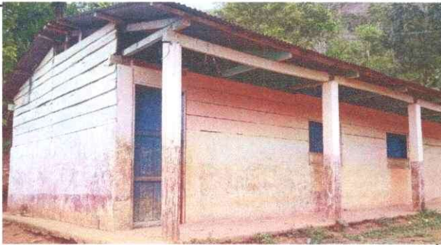
Foto 3: Las ventanas son de madera y se necesita cambiar por motivos de que no son muy adecuados para un aula y se siente demasiado calor dentro del edificio.
